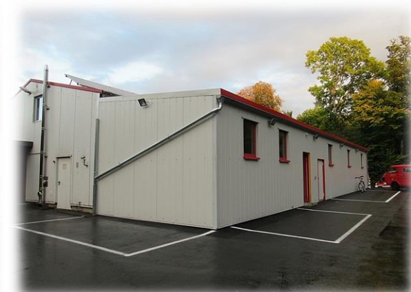
Der Anbau an das Feuerwehrhaus in Hohensolms.
